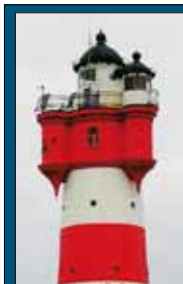
Leuchtturm Roter Sand mit Sunpower Cells
